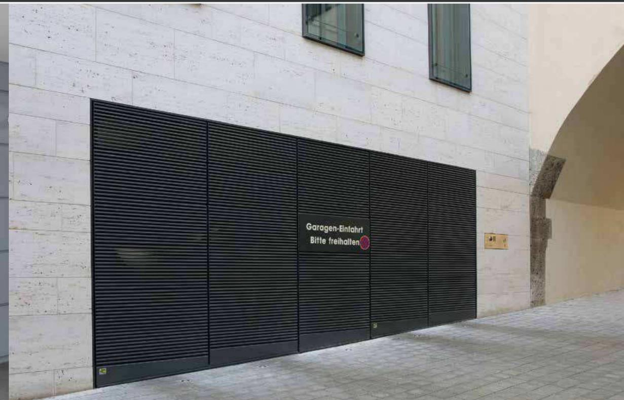
Tiefgaragenanlage, Beplankung mit Belu Tec Lüftungslamellen
