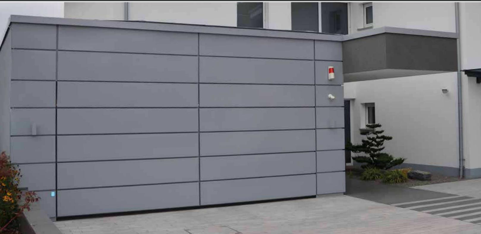
Beplankung mit Alukassetten, unsichtbar befestigt
