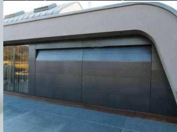
Tiefgaragenanlage, Beplankung mit Lochblechkassetten
