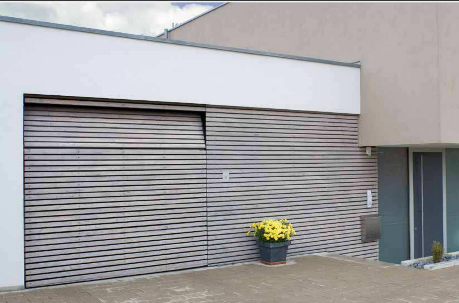
*Beplankung mit Holzlamellen, sichtbar befestigt*
