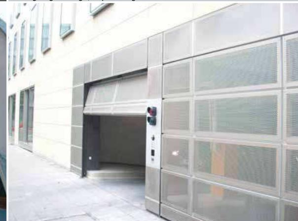
Tiefgaragenanlage, Beplankung mit Belu Tec Lüftungslamellen
