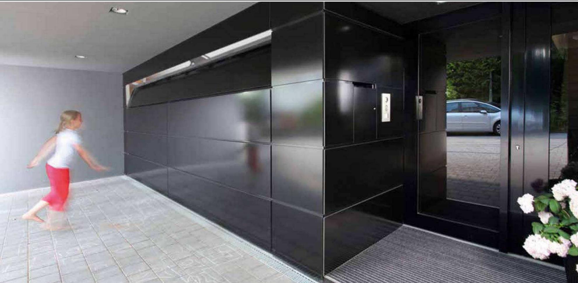
Beplankung der kompletten Eingangsanlage mit Hochglanzeffekt, unsichtbar befestigt, Torgewicht 480 kg
