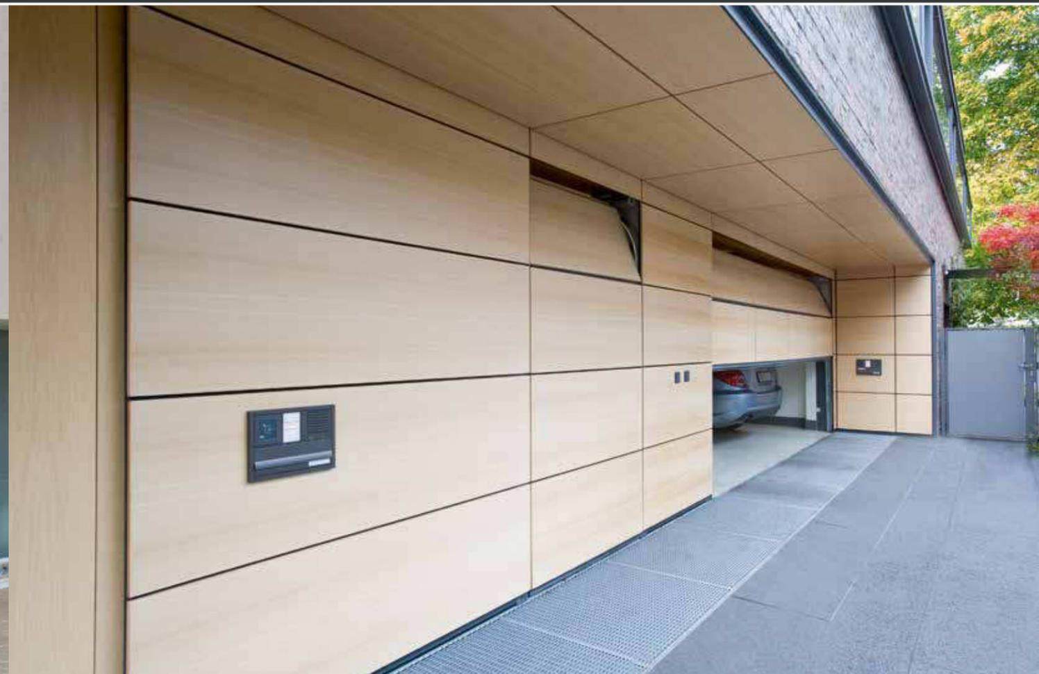
*Beplankung mit Holz Mehrschichtplatte 18 mm vorimprägniert, unsichtbar befestigt*
